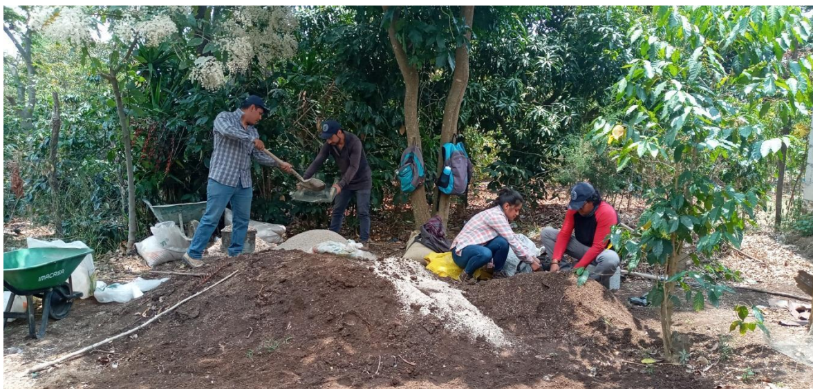
Figura 25 Preparación de tierra para el llenado de bolsas
