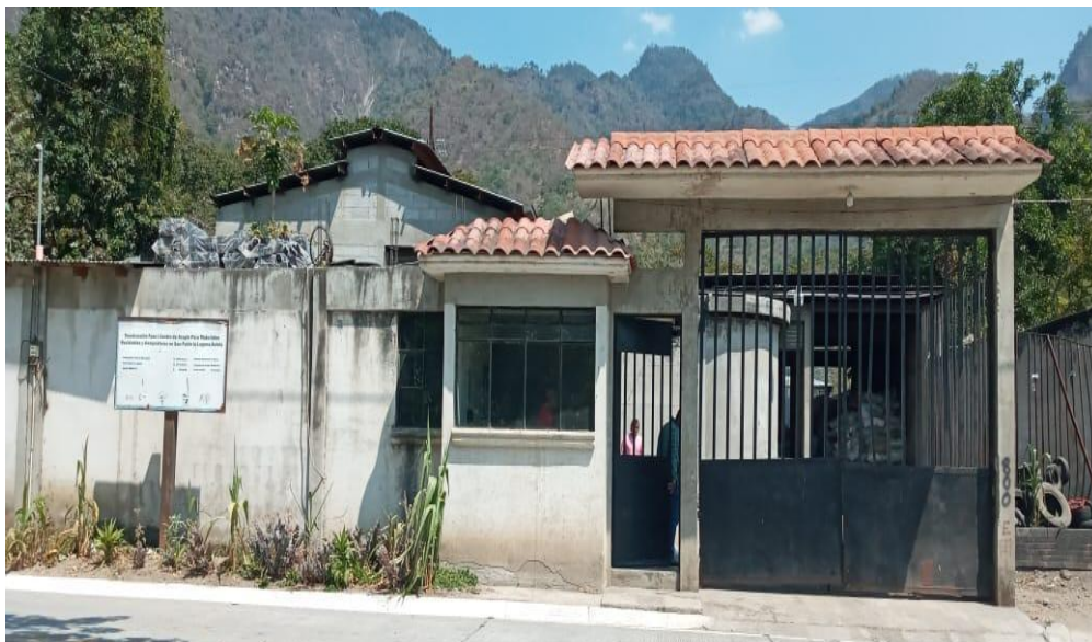
Figura 7 Centro de acopio de San Pablo La Laguna. Área destinada para la clasificación de basura. Fuente. José Bulux, epesista, 1C-2021.
