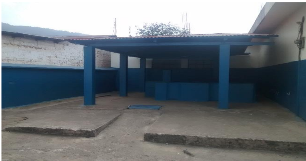
Figura 11. Tanque comunal de agua
