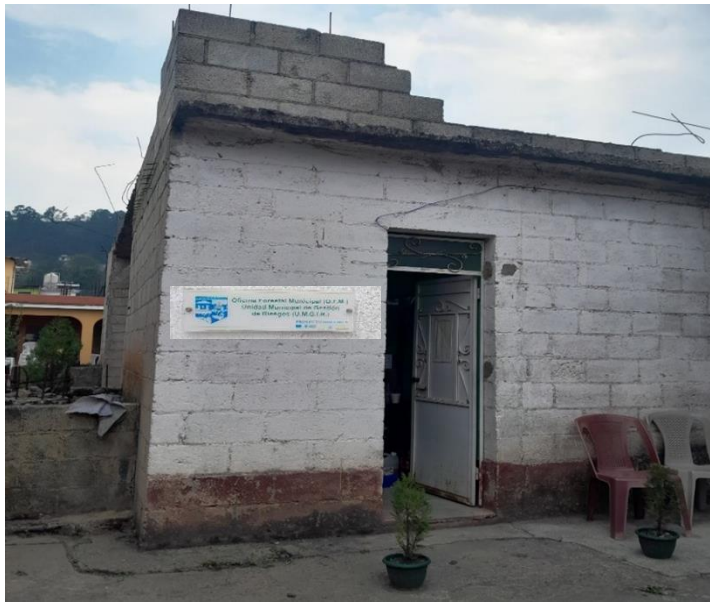
Figura 5. Espacio ocupacional de la Oficina Forestal Municipal.
