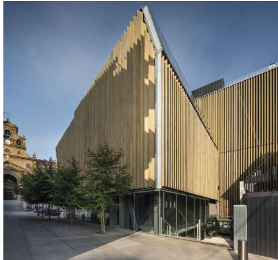
Fotografía 09 Fachada Lateral, Muxikebarri.
