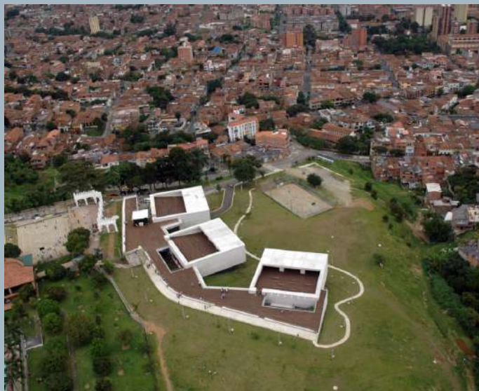
Figura 09 Vista aérea parque biblioteca León de Greiff, Medellín 45
