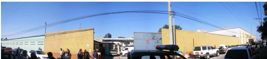
Fotografía 17– Vista fachada existente - Fuente: elaboración propia
