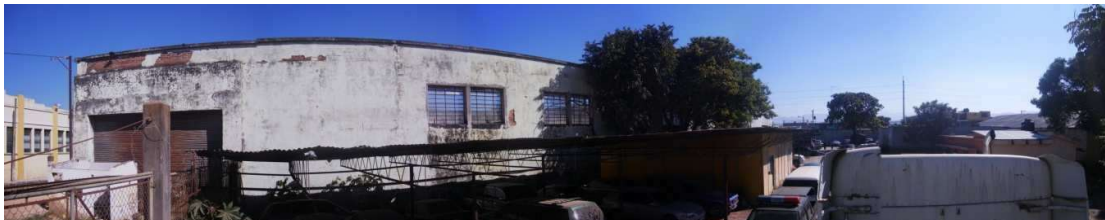
Fotografía 15 – Vista norte del terreno - Fuente: elaboración propia.
