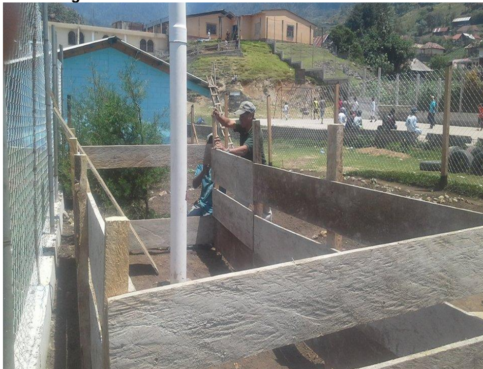
Figura 12: Construcción de tablón para implementación de lombricompostera.
