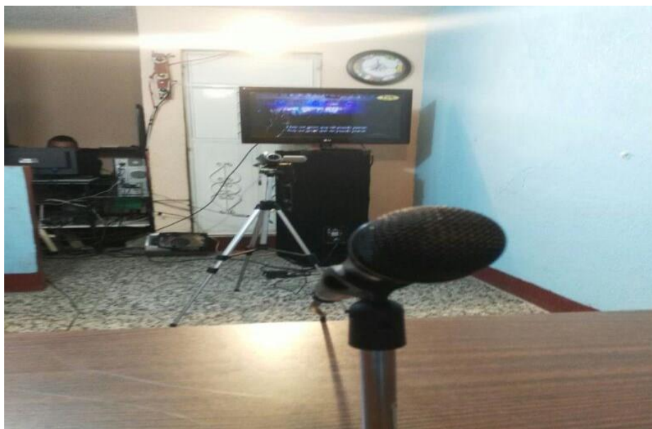
Figura 32: Cabina del cable local Maya Vista
