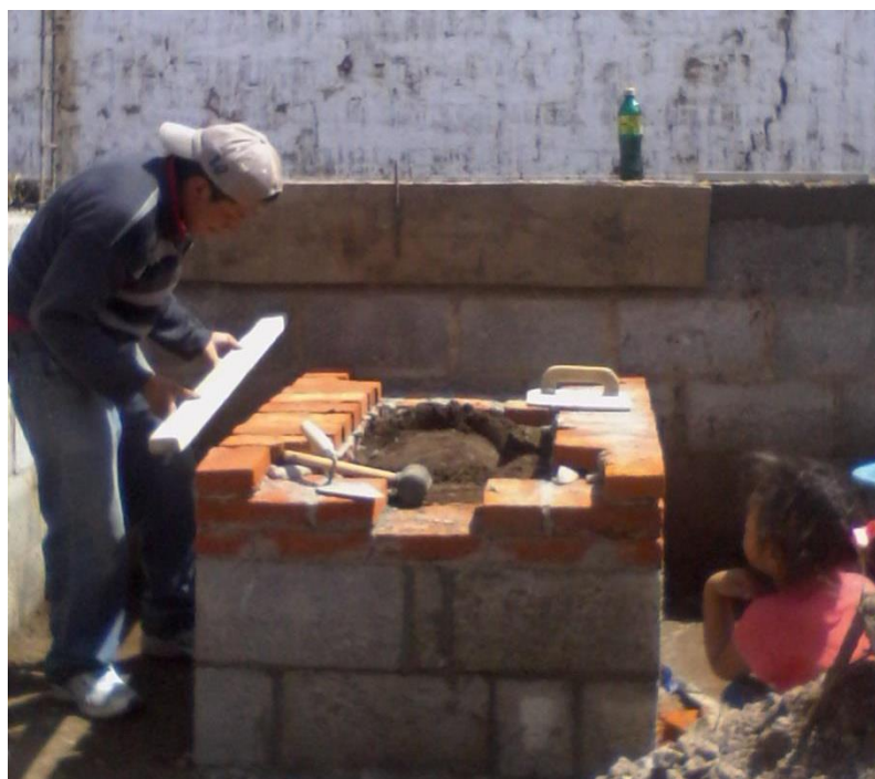
Figura 21. Albañil está construyendo una estufa ahorradora de leña.
