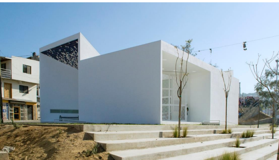
Figura 35. Exterior Biblioteca Casa de las Ideas.
