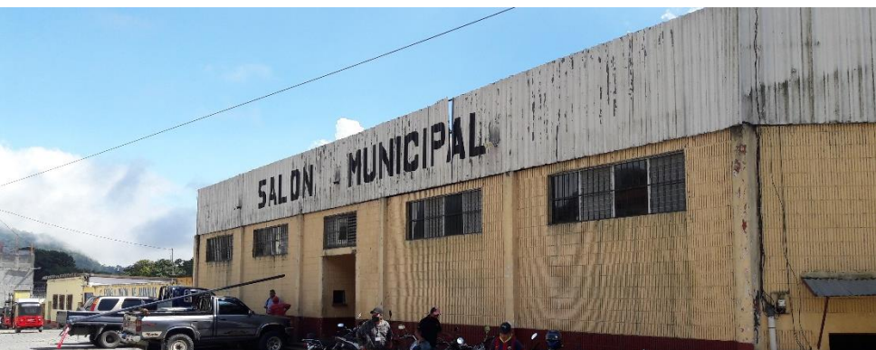
Figura 1. Salón Municipal de Purulhá. La propuesta del diseño del anteproyecto Biblioteca Municipal “Lic. Bernardo Lemus Mendoza” será reubicado en el casco urbano del municipio de Purulhá, en donde actualmente se ubica el Salón Municipal.
