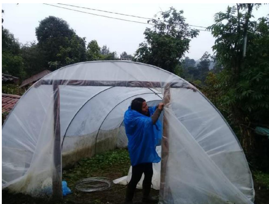
Figura 32. Instalación de invernaderos.
