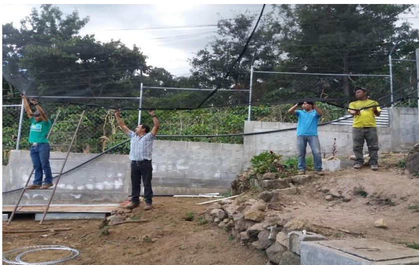
Figura 8. Instalación de alambre galvanizado para soporte del sarán. Construcción de la base para el vivero forestal municipal. Fuente. Rafael Zapeta, 11 de noviembre de 2019.
