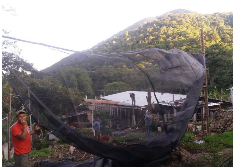
Figura 9. Colocación de sarán.
