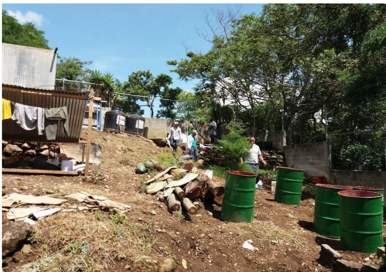
Figura 7. Medición del área, para la construcción del vivero forestal municipal. Se realizaron los trazos y medición de material de sarán a utilizar durante la construcción del vivero forestal. Fuente. Rafael Zapeta, 16 agosto de 2019.
