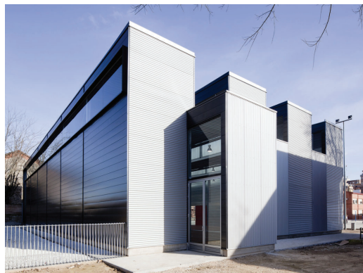
Ilustración 23: Vista lateral de Pabellón deportivo en el CP Pablo Iglesias Fuente: ArchDaily
