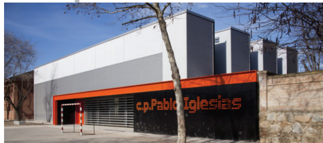
Ilustración 21: Pabellón deportivo en el CP Pablo Iglesias Fuente: ArchDaily
