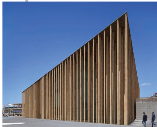
Ilustración 9: El Pabellón de España por Beloqui Fuente: Es la casa de la arquitectura
