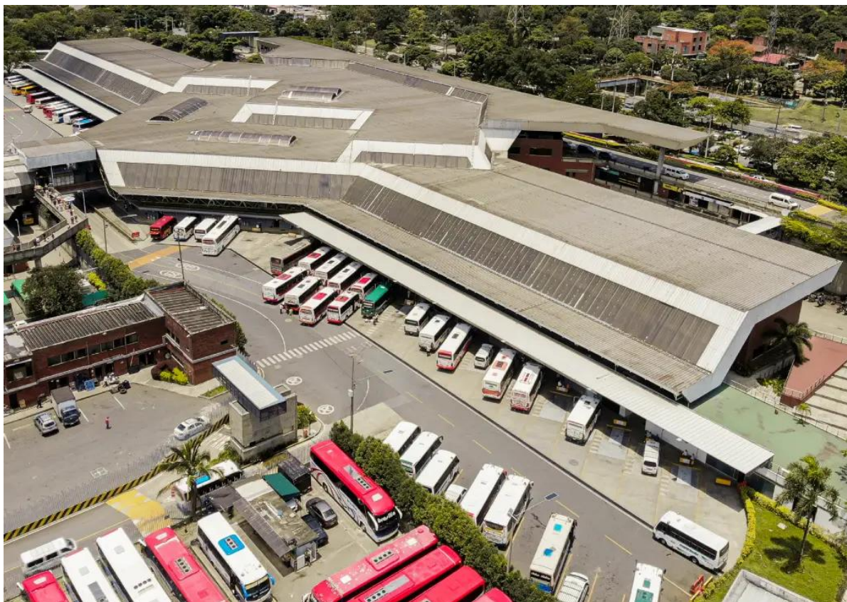
Figura 13. Terminal del Norte de Medellín, Colombia.
