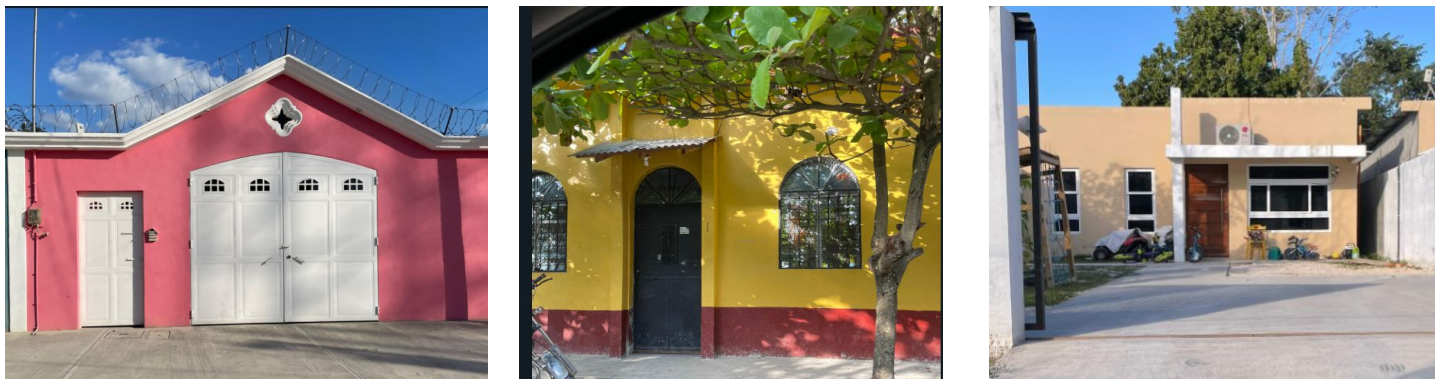
Fig 106. Imagen viviendas Fuente: Propia, visita de campo Junio 2023
