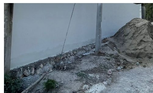
Fig 105. Imagen tipología constructiva de vivienda Fuente: Propia, visita de campo Junio 2023
