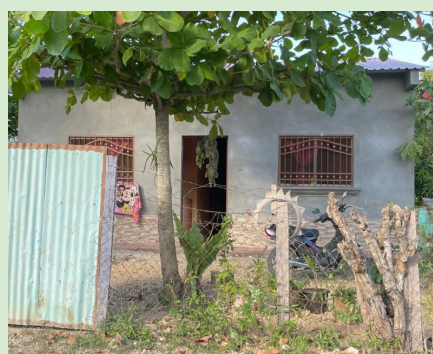
Fig 104. Imagen viviendas Fuente: Propia, visita de campo Junio 2023
