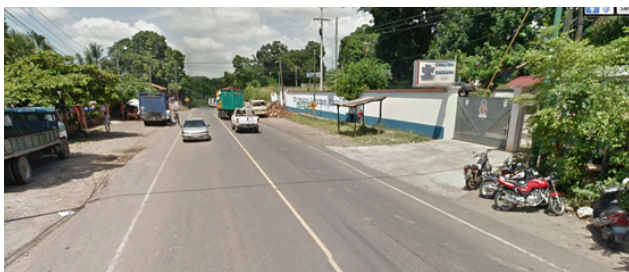
Figura 21. Fotografía vía primaria Elaboración propia en 2025
