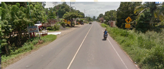
Figura 22. Fotografía vía primaria Elaboración propia en 2025
