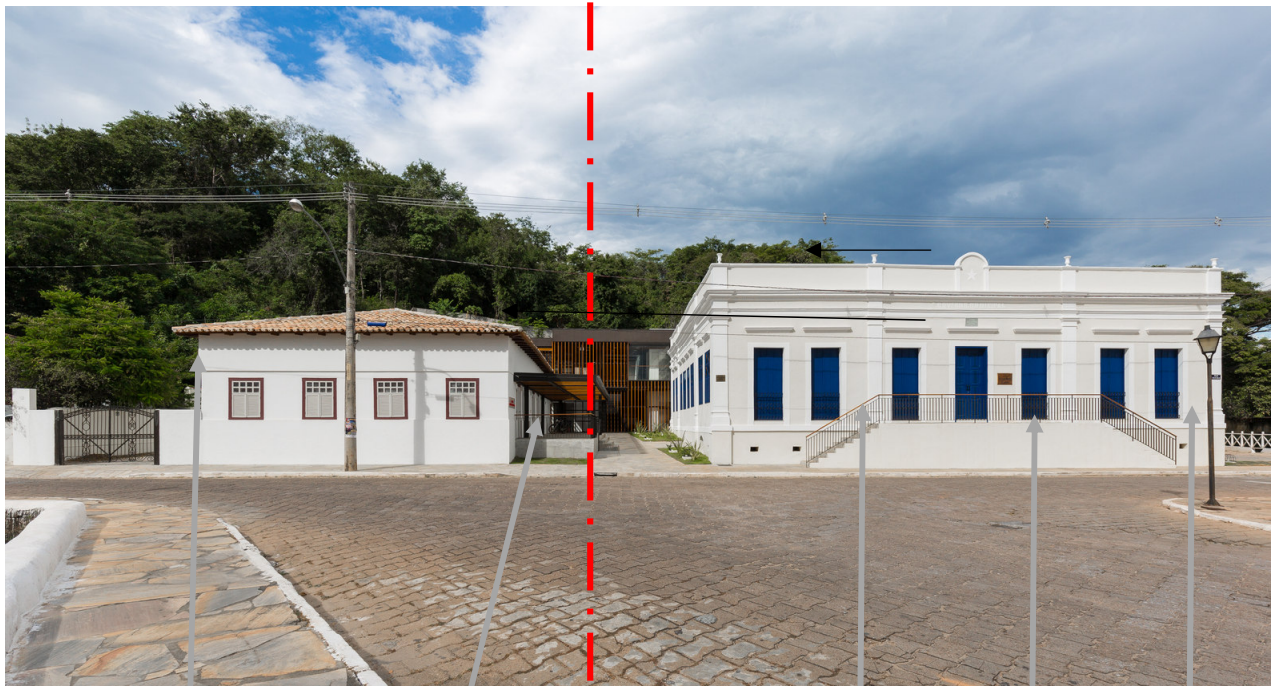
Figura 29. Fachada frontal de las edificaciones
