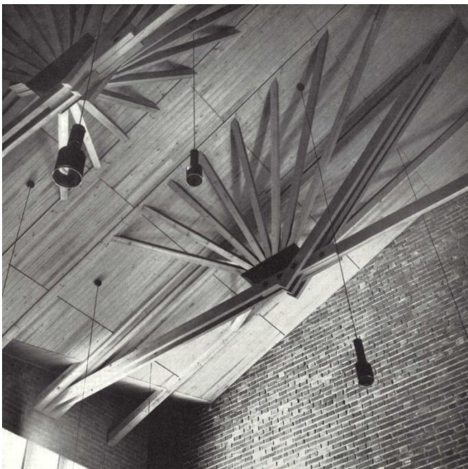
Figura 48. Estructura de ramillete de vigas de madera
