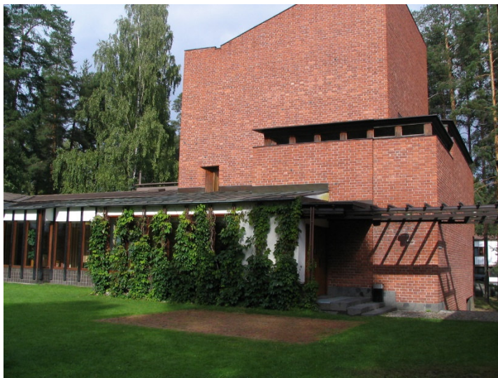
Figura 50. Fachada de edificio
