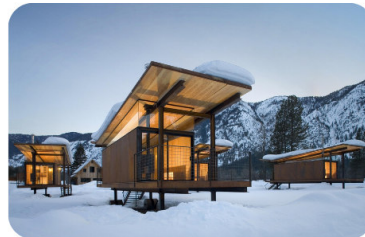
Rolling Huts, Estados Unidos, 2008, Plataforma Arquitectura
