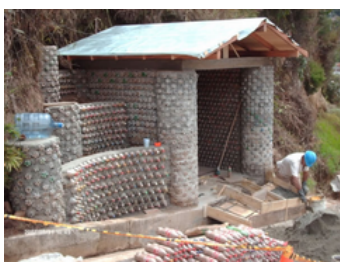
Figura 20. Ladrillos ecológicos de plásticos
