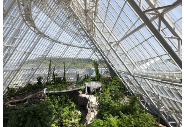
Figura 60. Ecorium del Instituto Ecológico Nacional, Plataforma Arquitectura
