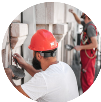
Figura 9. Disminución del mantenimiento, exploración y uso de los edificios
