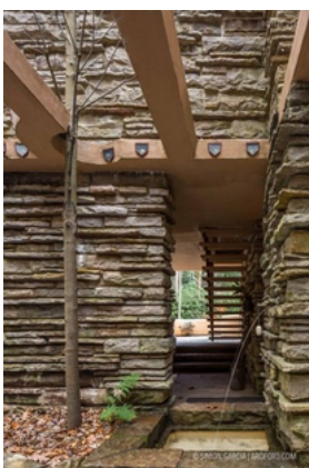
Figura 25. Casa de la Cascada, ingreso principal,
