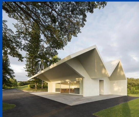
FIGURA 14: CASA DE TÉ EN EL CLUB DE GOLF TAIFONG EN DACUN
