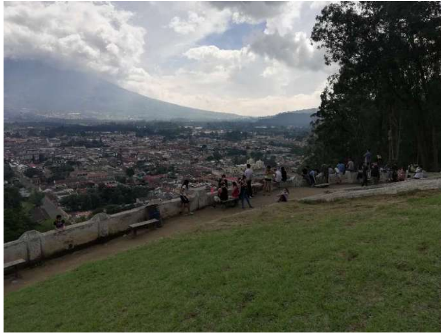
Fotografía No. 2: Se observa el área del Mirador de la Cruz y el muro original existente con poca infraestructura para los visitantes y en malas condiciones. Al fondo se observa lo espectacular de la vista de los volcanes, el valle y la ciudad en primer plano.
