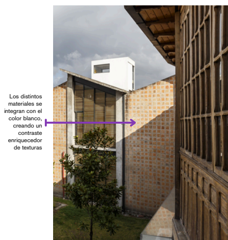
FIGURA 70: Fachada de Ladrillo y Hormigón. Obtenido de ArchDaily (Sebastián Crespo, Andrés Fernández, 2019).
