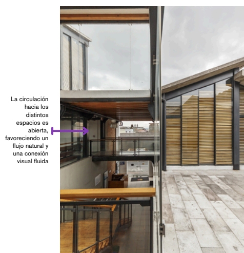
FIGURA 66: Estructura de la Edificación. Obtenido de ArchDaily (Sebastián Crespo, Andrés Fernández, 2019).
