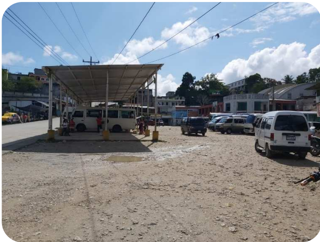
Figura 2. Actual estación de buses del Municipio de San Luis, Petén. Fotografía propia. (San Luis, Petén, 2020).
