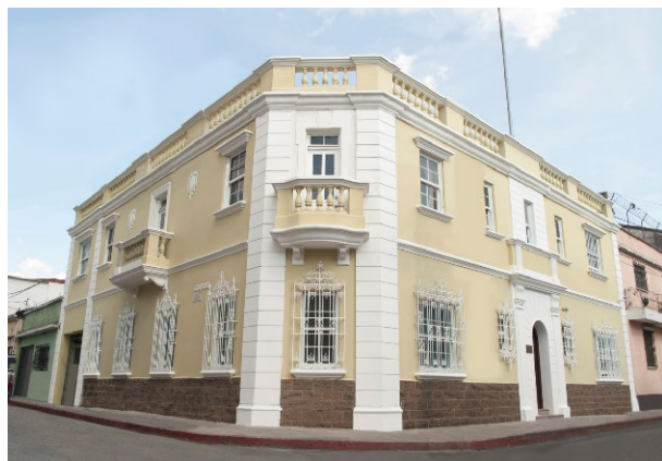
Casa Ronald #3, ubicada en zona 1 capitalina.
