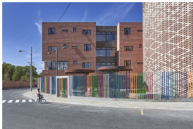
Casa Ronald #1, ubicada en zona 11 capitalina.
