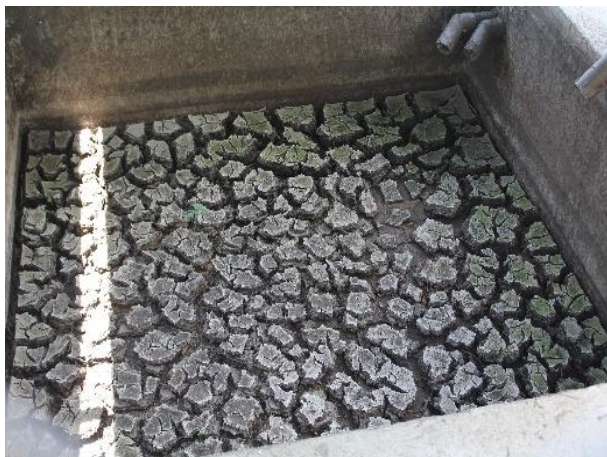
Figura 131. Patio de lodos
