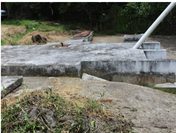
Figura 151. Caja de rejas y fosa septica
