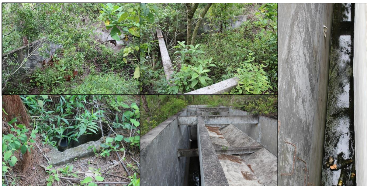
Figura 161. Estado actual de la PTAR en Santa Bárbara
