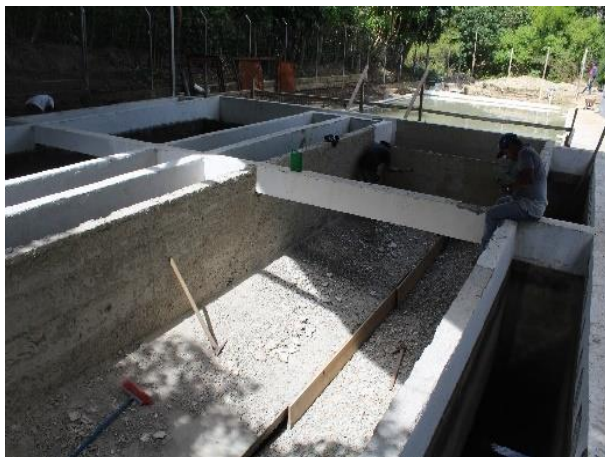
Figura 109. Tanque mejorado en un reactor anaerobio de flujo ascendente (RAFA)
