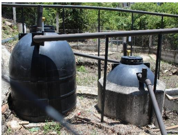
Figura 134. Filtro anaerobio y sedimentador
