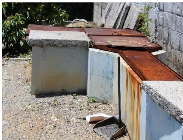
Figura 135. Canal de rejas y desarenador
