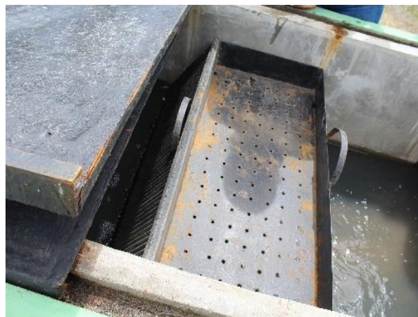
Figura 165. Desarenador
