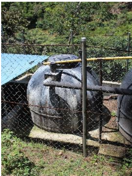
Figura 127. Sedimentador-Clarificador
