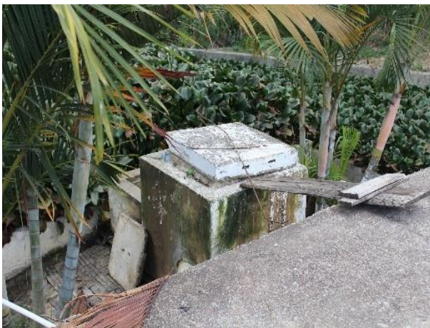
Figura 159. Salida hacia el patio de lodos
