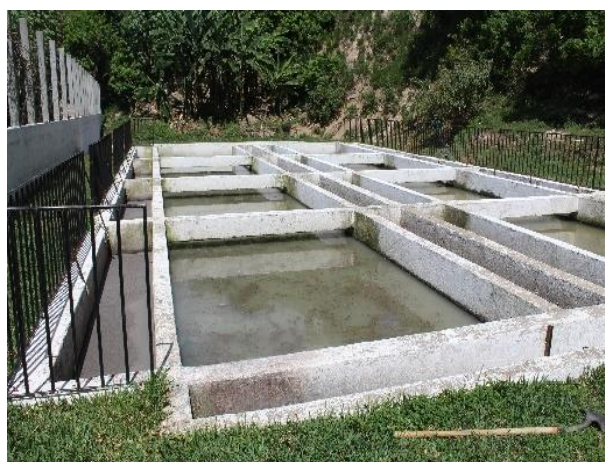
Figura 113. Tanques Imhoff
