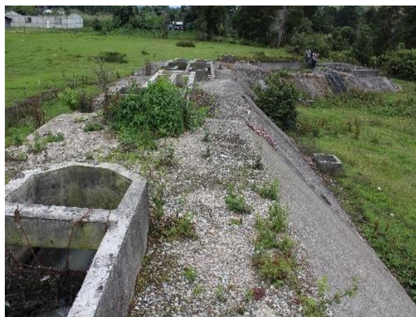
Figura 97. Vista general de la PTAR
