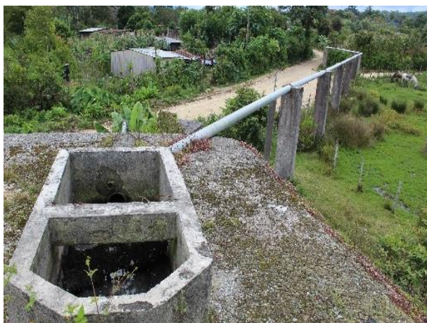
Figura 96. Entrada del drenaje
