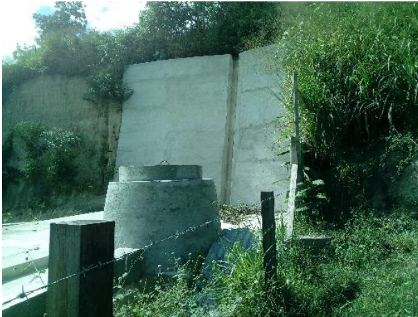
Figura 92. Vista de frente PTAR
