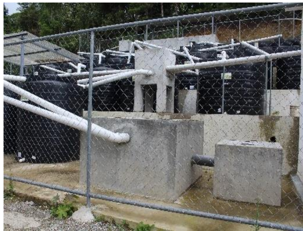
Figura 175. Vista lateral de la PTAR
