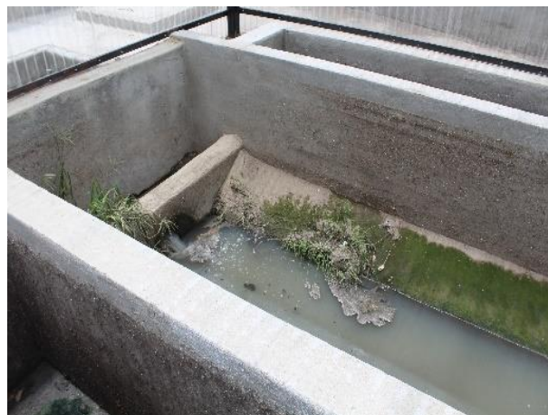
Figura 124. Sección interna tanque Imhoff
