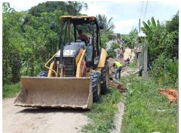
Figura 119. Reposición del Alcantarillado
