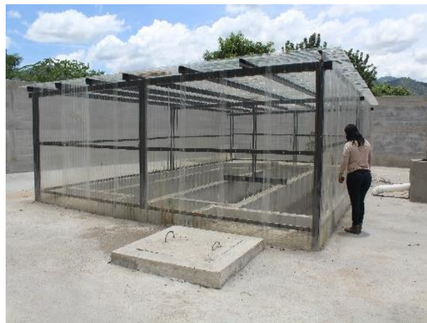
Figura 122. Tanques Imhoff
