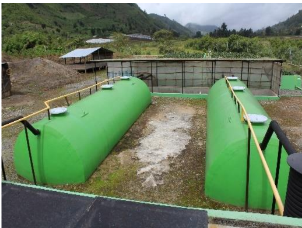
Figura 166. Reactores biológicos
