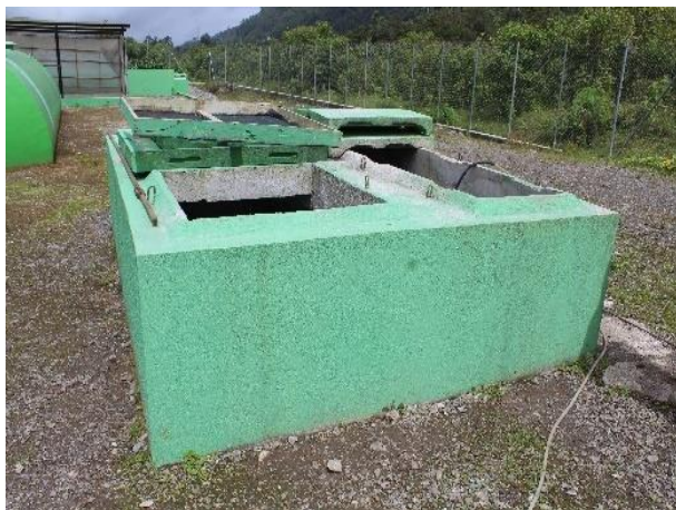
Figura 162. Caja de demasías
