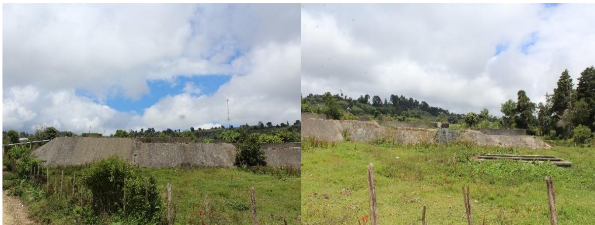
Figura 95. Vista frontal Planta de Tratamiento
