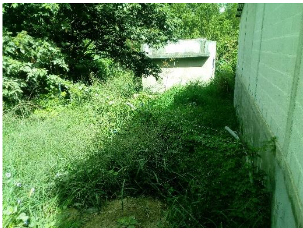
Figura 102. Entrada a la PTAR
