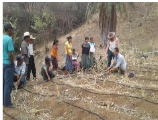
Ilustración 36 Demostración de reparación de fugas en cintas de goteo, Pichal Fuente: EPS CECI 2018
