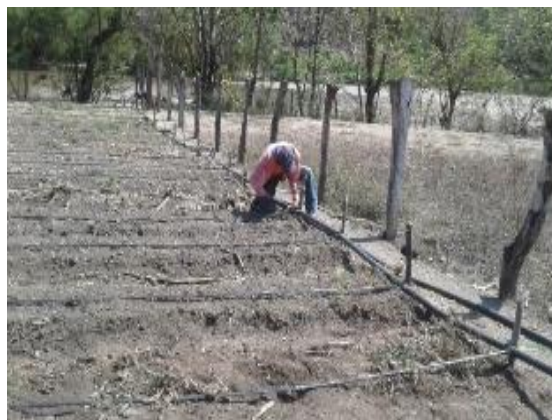
Ilustración 30 Instalación de sistema de riego, Chirramos Fuente: EPS CECI 2018
