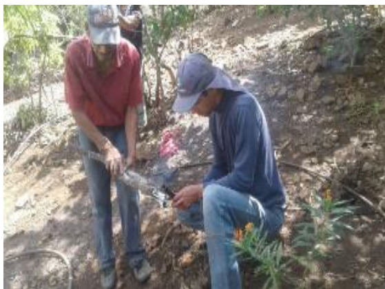
Ilustración 27 Instalación de riego por goteo, Patuy Fuente: EPS CECI 2018
