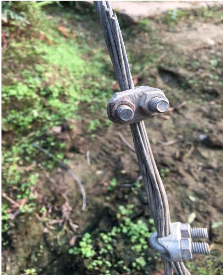
Figura 6. Cableado y clamps utilizados en el umbráculo Fuente. Propia EPS 2019.
