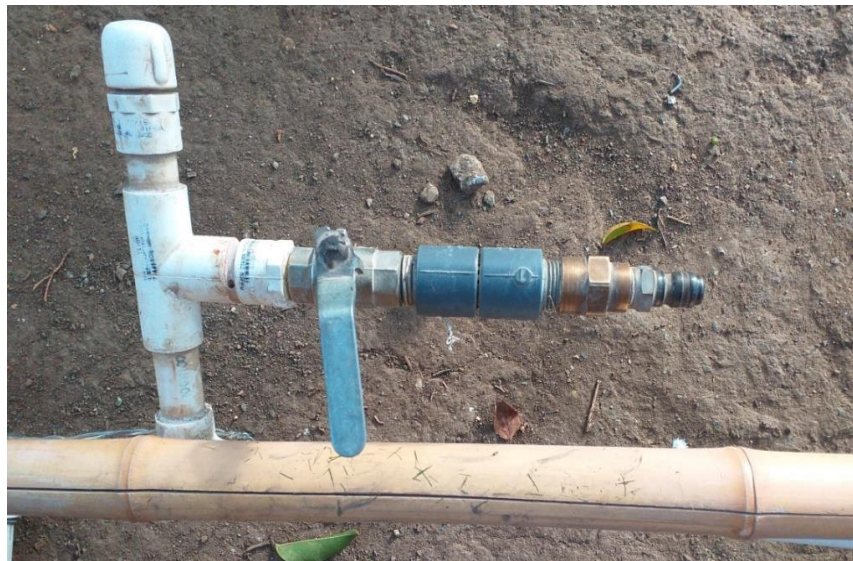
Figura 50. Acople del aguilón para la manguera de distribución con la llave de paso.
