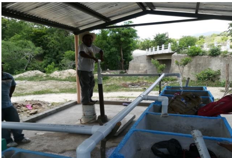
Figura 60A. Instalación de bomba Manual Tipo Maya en aldea el Progreso.
