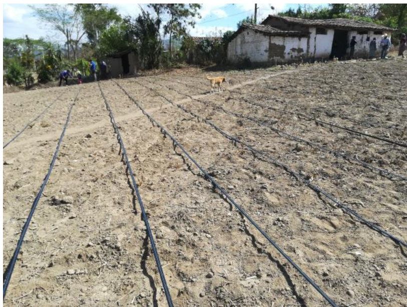
Figura 43A. Instalación de cintas de goteo
