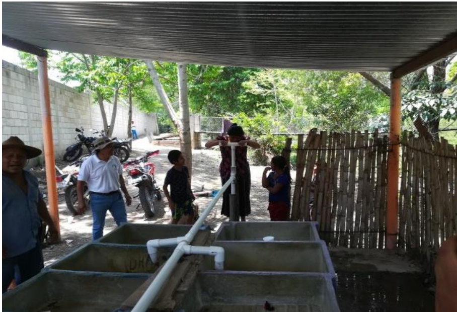
Figura 59 A. Instalación de bomba Manual Tipo Maya en la Comunidad de San Gabriel.
