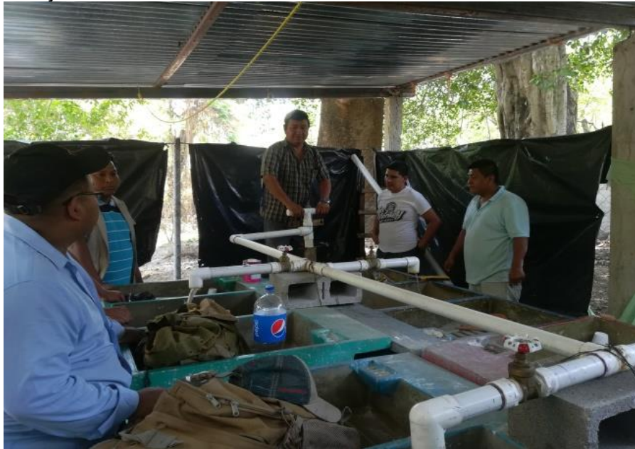
Figura 58 A. Instalación de bomba Manual Tipo Maya en la Comunidad de Chilajom.
