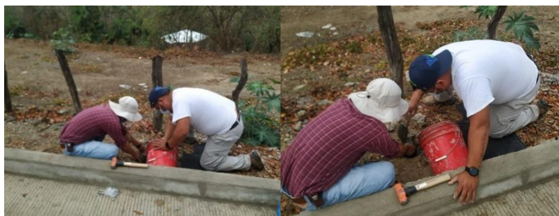
Figura 78. “A” Monumentación y geoposicionamiento de la Red de Apoyo Catastral (RAC) de orden II.
