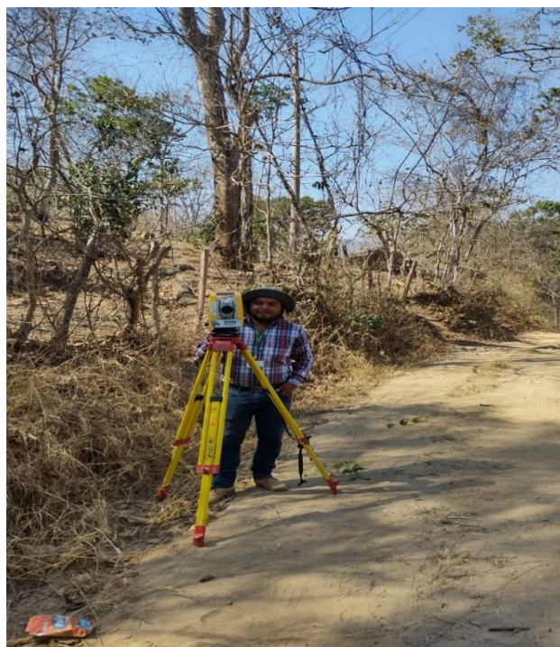
Figura 63. Levantamiento de las calles con estación total
