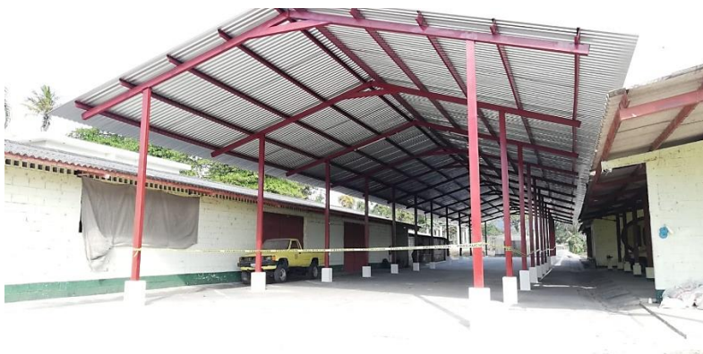
Figura 12. "A" Nuevo patio de secado
