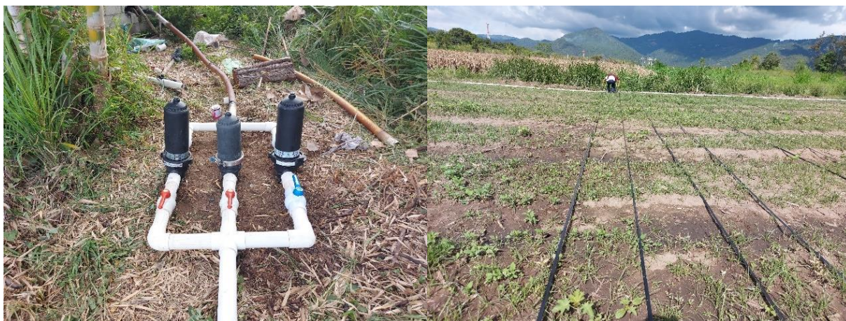
Figura 33. "A" Instalación del sistema de riego
