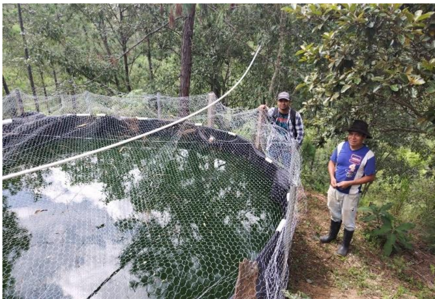
Figura 107 “A”. Monitoreo de charcas con geomembrana.
