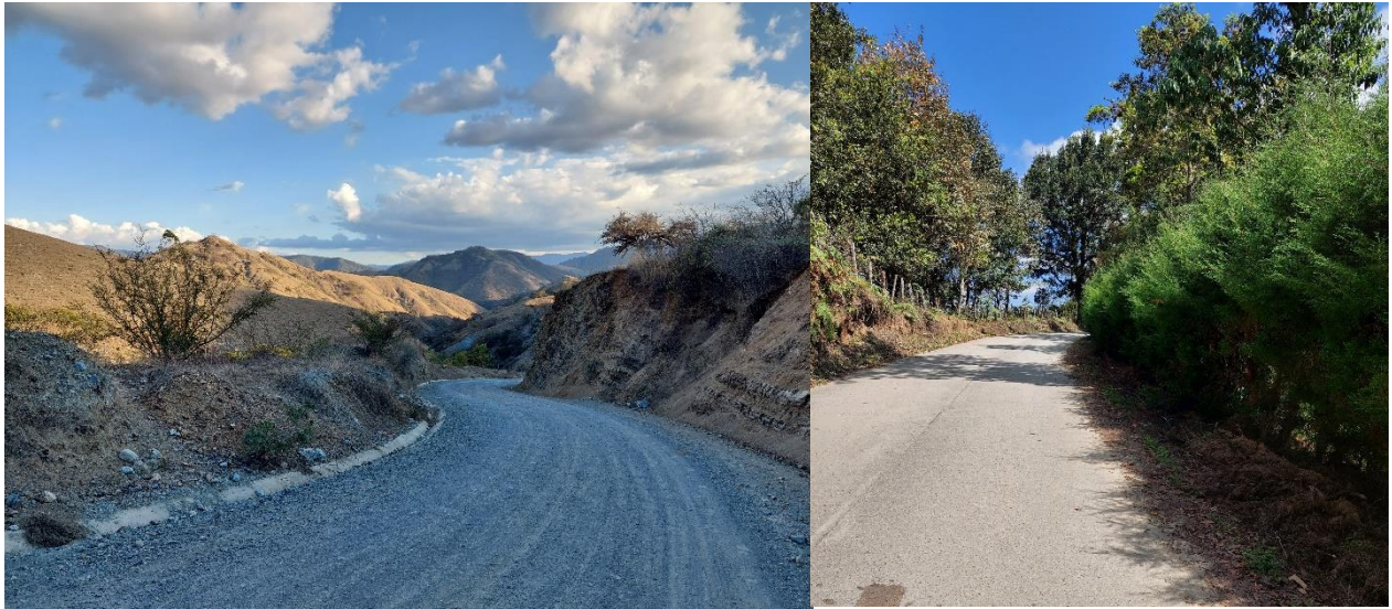
Figura 15 “A” Carreteras de terracería y tramos de asfalto
