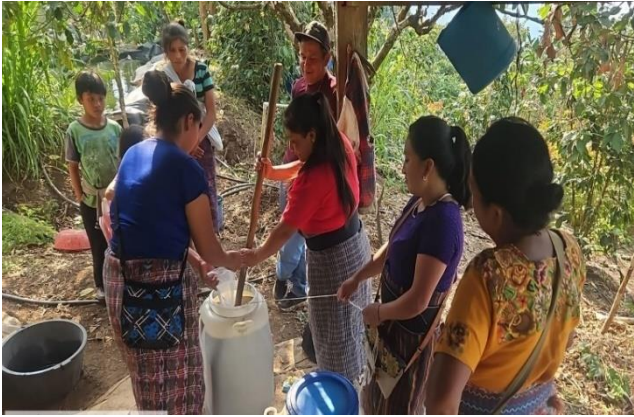
Figura 74A Mezcla de materiales líquidos
