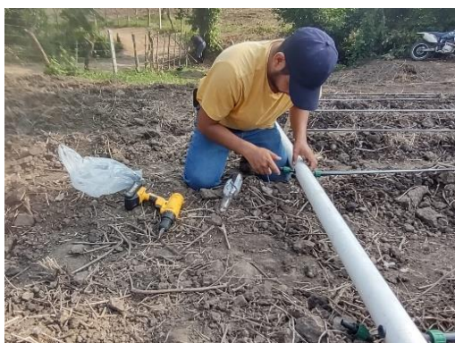
Figura 47 "A" Instalación de sistema de riego por goteo, colocando conector inicial para cinta de goteo.
