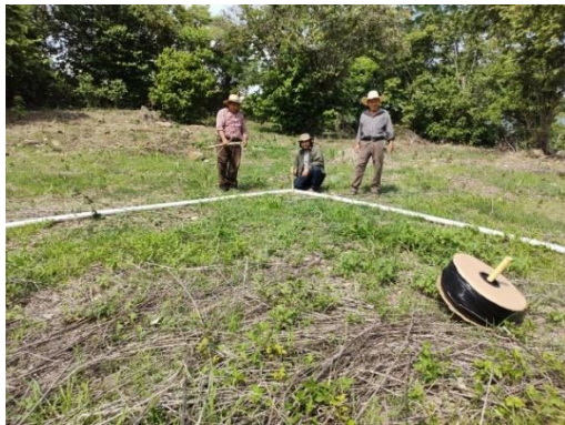
Figura 43 "A" Instalación de sistema de riego por goteo, conectando tubería central.
