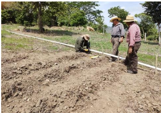
Figura 45 "A" Instalación de sistema de riego por goteo Aldea Dolores, perforando tubería secundaria.
