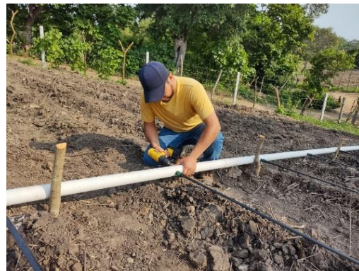
Figura 46 "A" Instalación de sistema de riego por goteo, aldea Dolores: Perforando tubería secundaria.
