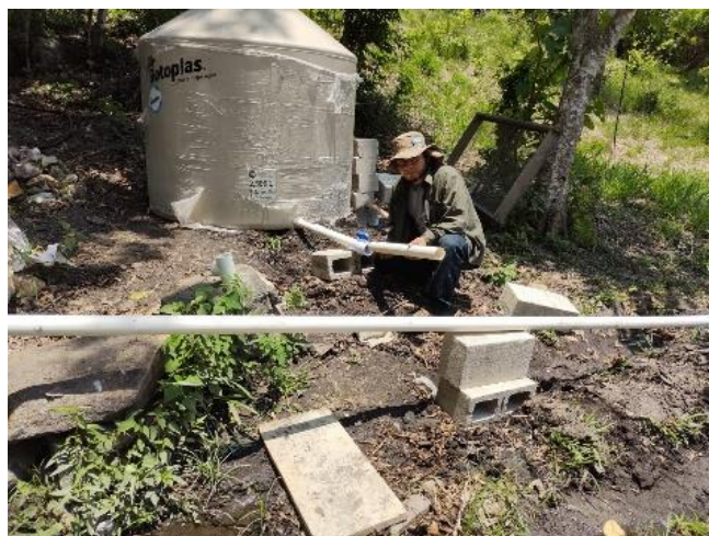
Figura 49"A" Instalación de sistema de riego por goteo en Rincón San Pedro, conectando tinaco a la tubería central.
