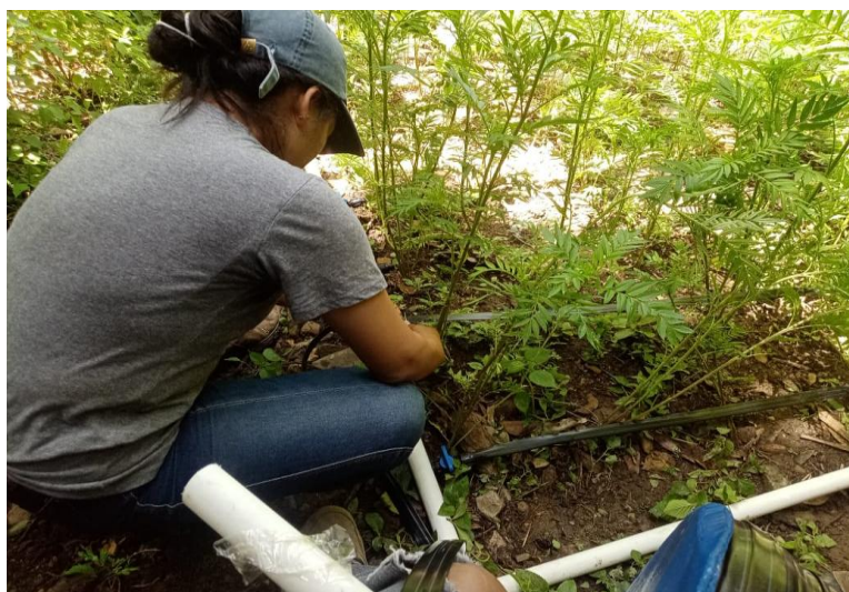
Figura No. 44 Inserción de cinta de goteo a tubería principal de conducción de agua.
