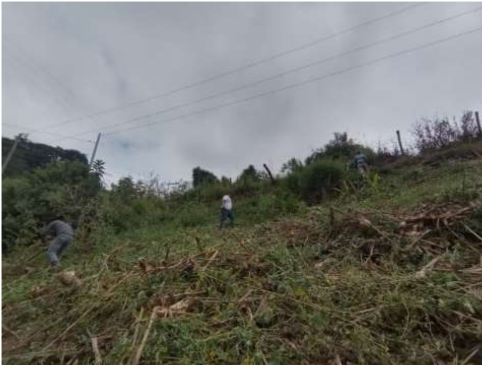
Figura 15. Limpieza del terreno
