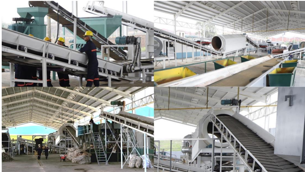
Figura 20. Interior Planta Separadora de Desechos Sólidos, AMSA.
