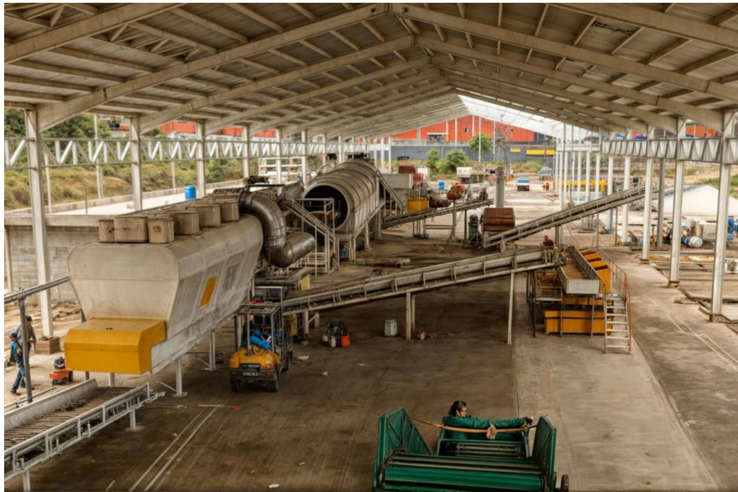
Figura 21. Interior Planta Separadora de Desechos Sólidos, AMSA.
