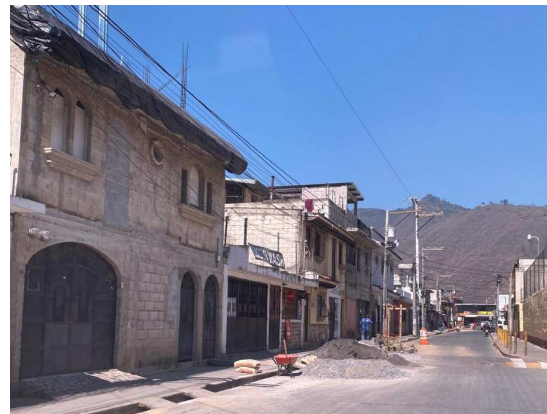
Figura 73. Tipología y Tecnologías Constructivas Fuente: Fotografía propia
