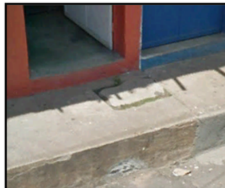
Figura 101. Acometida de agua potable en el casco urbano de Chiquimulilla. Fuente: Google Earth, 2024.
