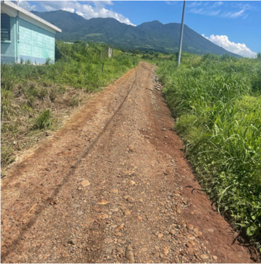
Figura 114. Calle no asfaltada en el entorno del proyecto. Fuente: Pablo Perussina, 2024.
