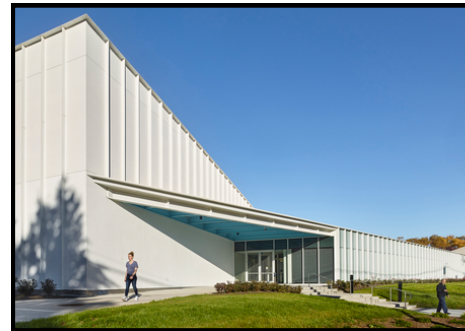
Figura 25. Apunte exterior del proyecto diseñado por Ikon.5 Architects. Fuente: ArchDaily México.
