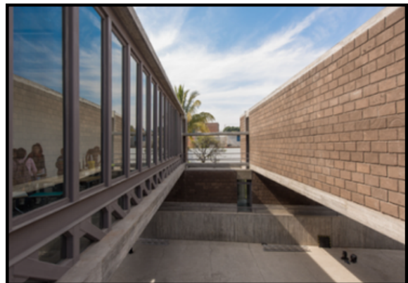
Figura 48. Apunte exterior del proyecto diseñado por Mauricio Rocha + Gabriela Carrillo. Fuente: ArchDaily México.
