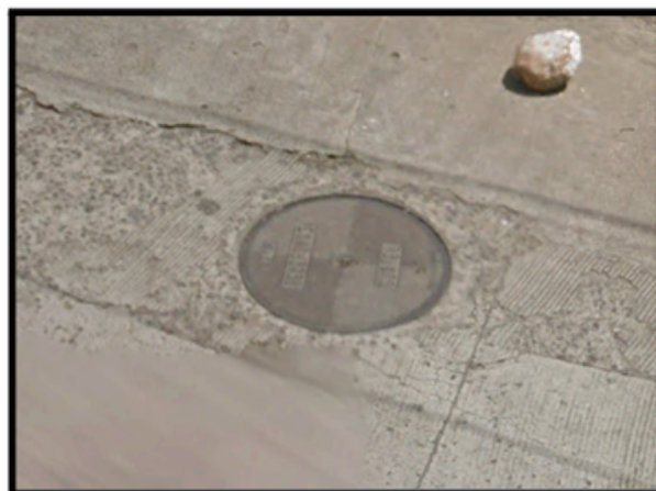
Figura 102. Alcantarilla de drenaje sanitario en el casco urbano de Chiquimulilla. Fuente: Google Earth, 2024.
