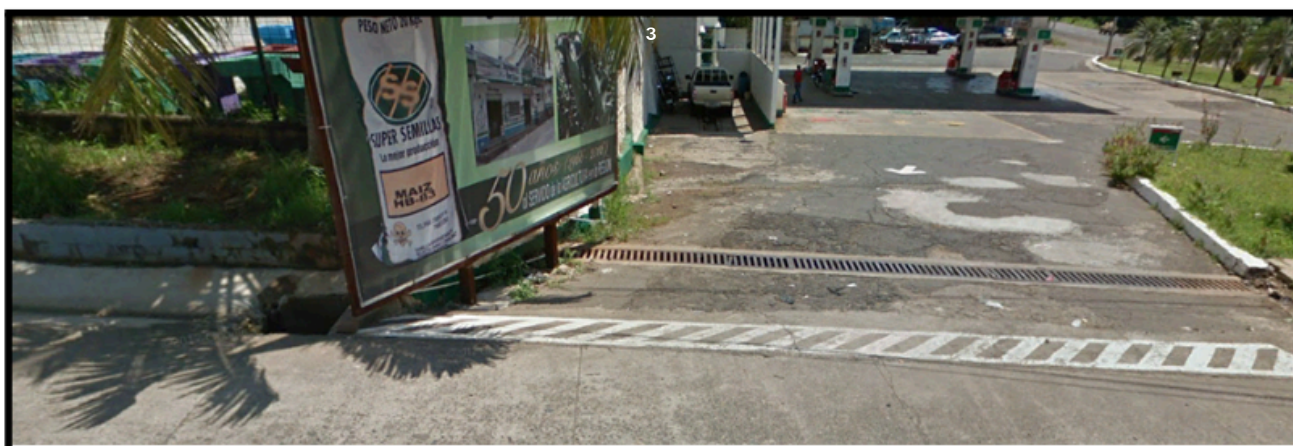
Figura 103. Drenaje pluvial mediante cunetas en el casco urbano de Chiquimulilla. Fuente: Google Earth, 2024.
