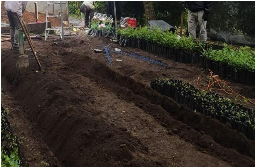
Figura 12. Construcción de terrazas para plantas forestales.
