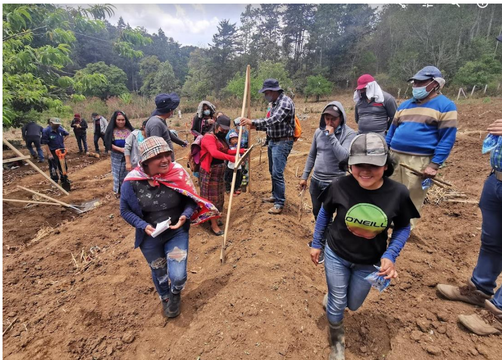
Figura 24 Trabajo de limpieza en estructuras preventivas, Parcialidad Vásquez Oztiles marzo 2022
