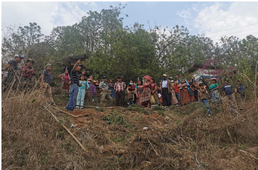
Figura 20 Planificación y trabajo de estructuras preventivas marzo 2022
