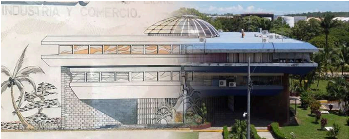
Figura 50, Edificio Administrativo ZOLIC,
