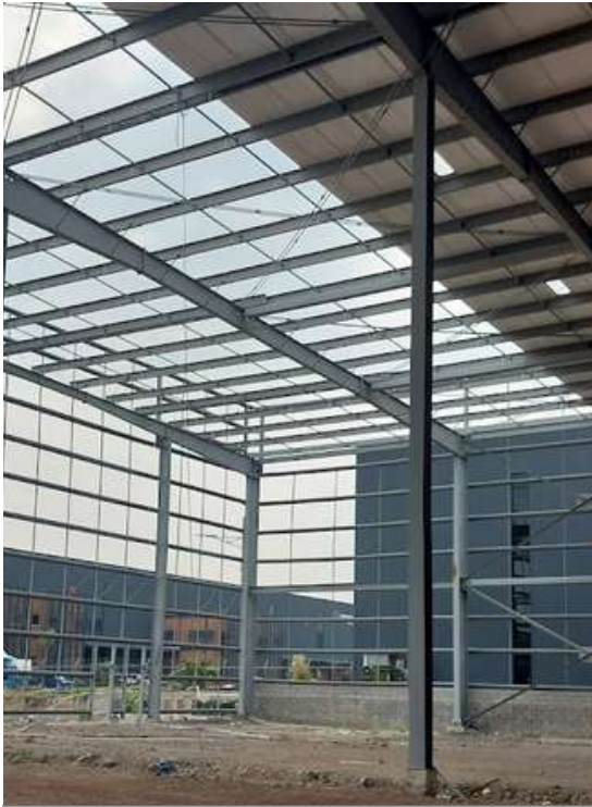
Figura 29, Michatoya Pacifico estructura metálica, Fuente: Fotografía propia, Jessica Ramírez, 2024.
