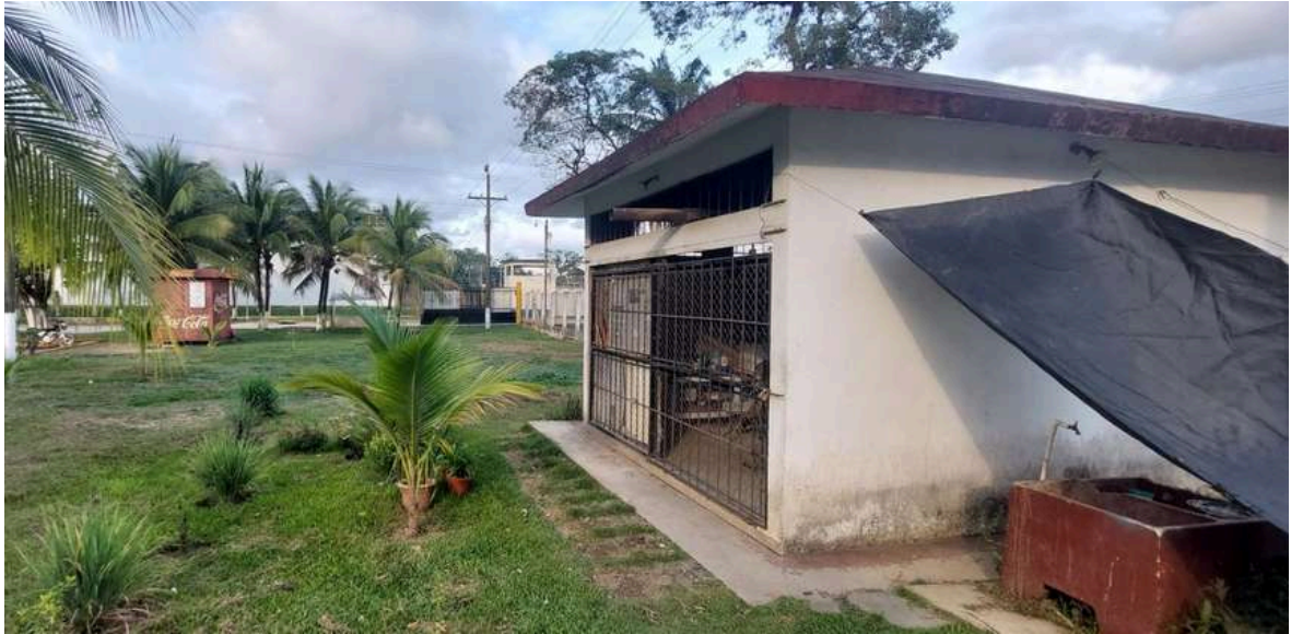
Figura 68, Área techada existente, Fuente: Elaboración propia, Jessica Ramírez, 4 de marzo 2024. Se observa un área techada que se encuentra a la par de la caja, actualmente hay equipo resguardado, a la par se encuentra una pila que se utiliza para el área de mantenimiento.
