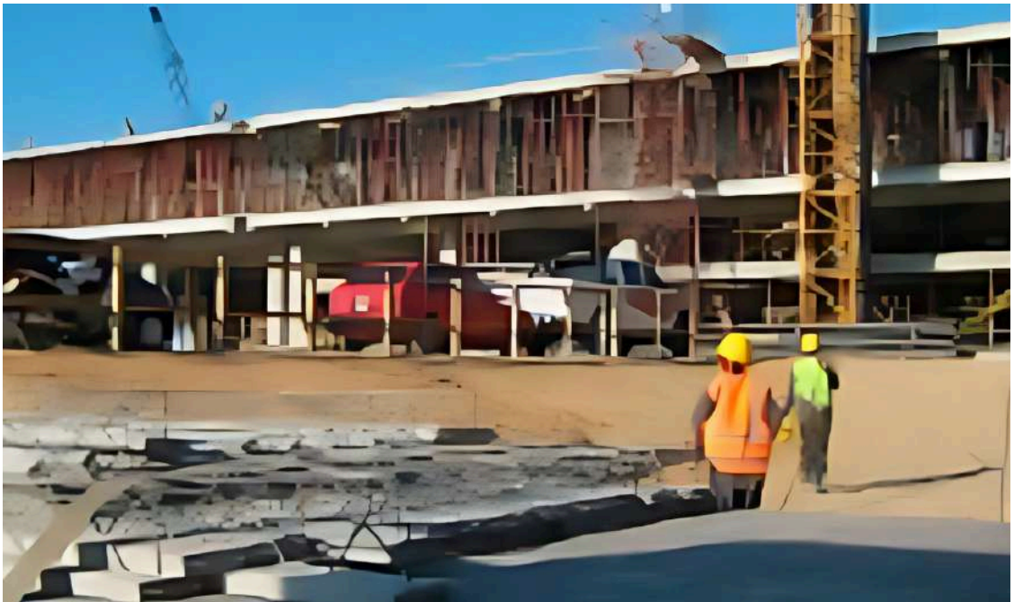
Figura 29: Construcción de marcos rígidos
