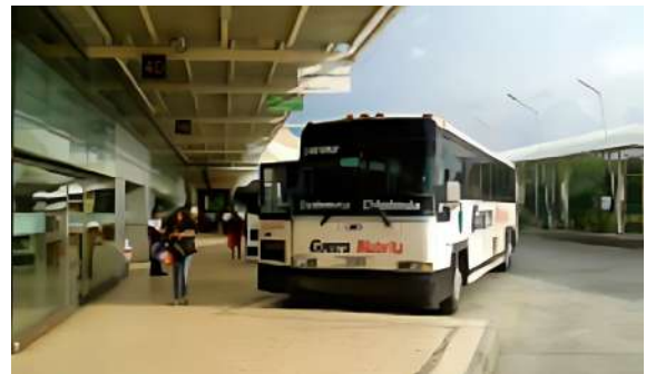
Figura 18: Parada de Buses Fuente: https://xplorandoguatemala.com/viajes-y-turismo/centra-norte-central-de-transferencias-al-nororiente-de-guatemala Comentario: altura de 4.50 mts material de lámina sin protección a la lluvia
