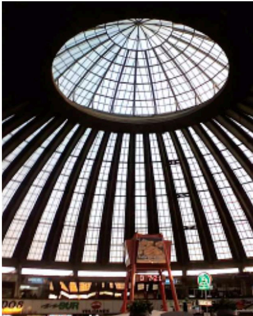
Figura 41: Cubierta de acero
