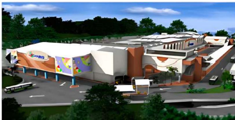
Figura 24: Central de Transbordo "Centra Norte" Fuente: https://vidamasverde.com/2012/central-de-transbordo-centra-norte-en-guatemala-esta-en-proceso-de-certificacion-leed/
