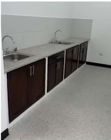
Fotografía 11: Área de servicio
