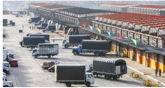
Fotografía 31. Área de carga y descarga de bodegas. Fuente: Google Maps, 2017.
