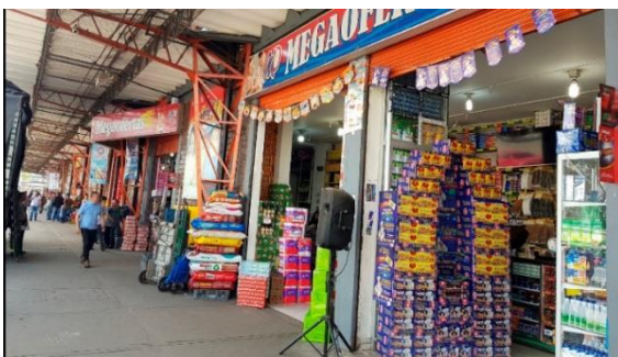
Fotografía 35. Área de ventas exteriores. Fuente Google Maps, 2017.
