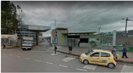
Fotografía 30. Ingreso a la Central Mayorista de Bogotá. Fuente: Google Maps, 2017.
