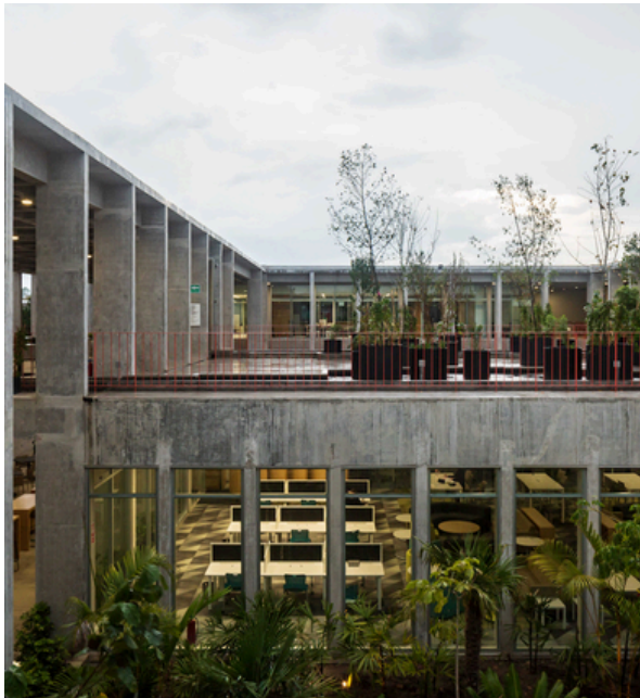
Figura 37. Vista interior C. 2018
