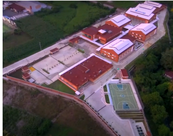
Figura 44. Vista de conjunto. 2025
