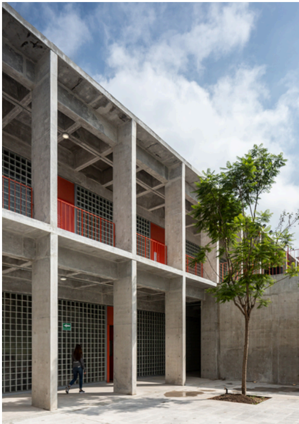
Figura 39. Vista interior E. 2018
