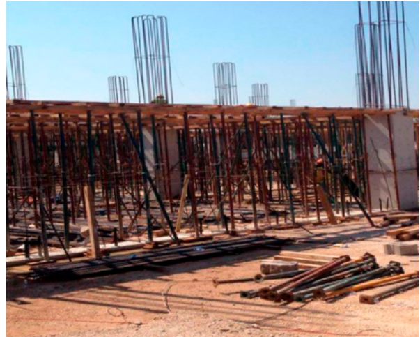
Figura 53. Construcción del complejo. 2025
