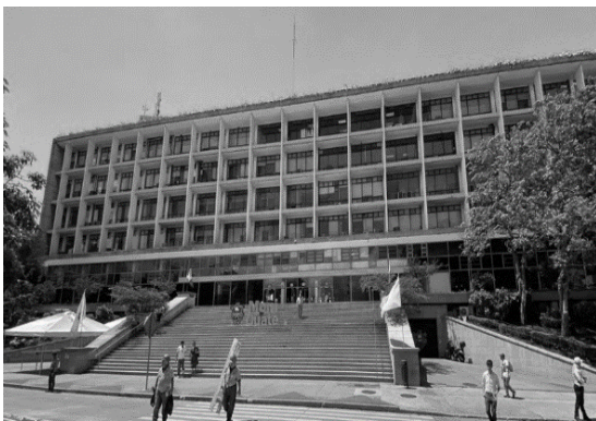
Fotografía 8. Fachada Palacio Municipal Fuente: elaboración propia
