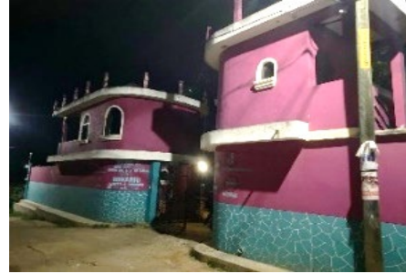
Fotografía 32 Fachada Fuente: Foto propia
