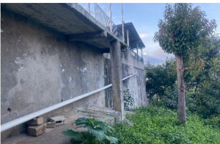
Fotografía 31. Muro contención. Fuente: Foto propia
