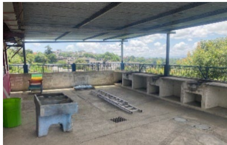
Fotografía 34: Techo lámina Fuente: Foto propia
