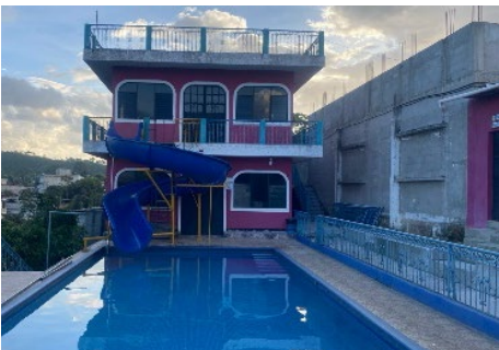
Fotografía 30. Piscina existente. Fuente: Foto propia
