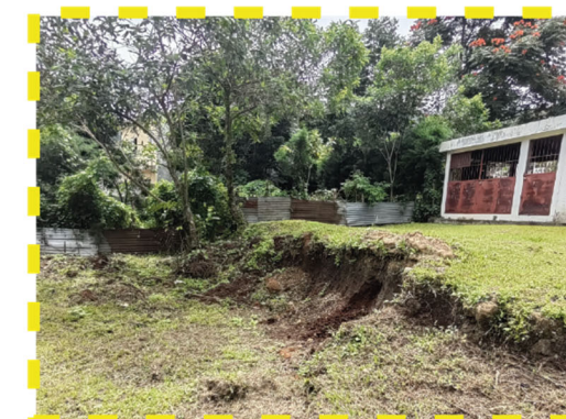
vista en el terreno
