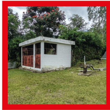
pozo y garita de control
