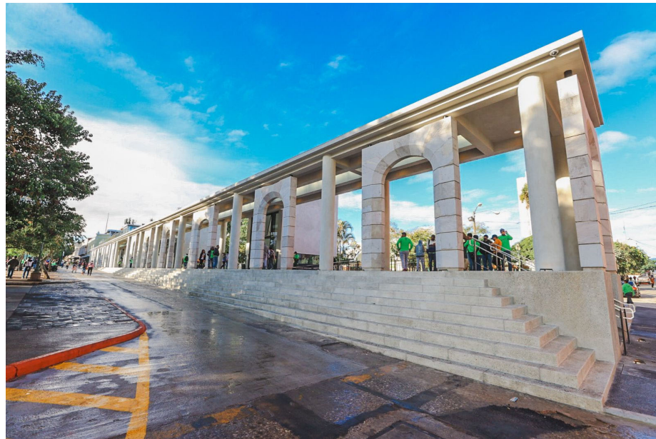
Figura 9. Nuevo portal de la Plaza Central. Foto de la Municipalidad de Guatemala. Guatemala
