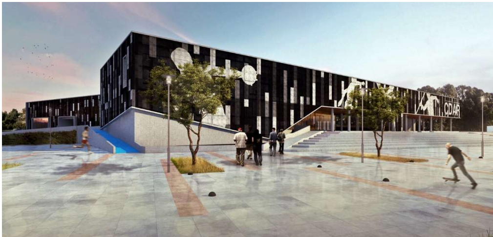
Figura 18. Flabio Valenzuela, Fotografía de "Centro deportivo Alto Rendimiento (CDAR)", Chile 2016, https://www.archdaily.mx/mx/792170/centro-deportivo-alto-rendimiento-uno-de-los-10-proyectos-ganadores-del-cnpt-2016
