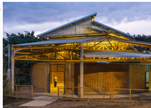
Figura 56. Centro Comunitario de El Rodeo de Mora. Fotografía de: Fernando Alda, https://www.archdaily.cl/cl/796237/centro-comunitario-de-el-rodeo-de-mora-fournier-rojas-arquitectos
