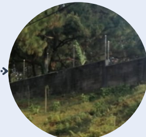
Figura 159. Foto muro perimetral existente en terreno, elaboración propia.
