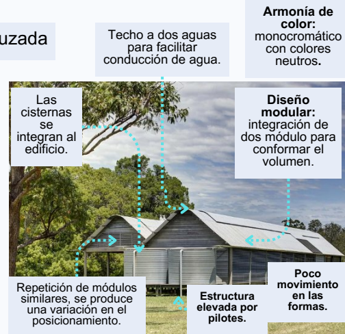
Figura 26. Casa Marie Short House (1974) por Glenn Murcutt, Fotografía de: Brett Boardman (2023), https://www.urbipedia.org/hoja/Casa_Marie_Short
