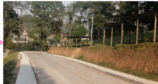
Figura 150. Fotografía 1 de terreno, elaboración propia.
