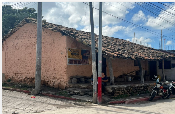
FOTOGRAFÍA 39 Viviendas antiguas aun de adobe, existentes en el municipio de Agua Blanca, Jutiapa. Fuente: fotografía propia
